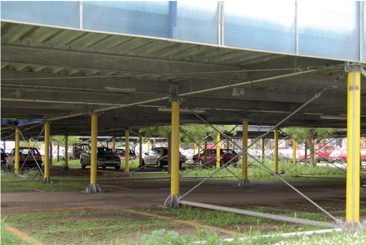
Ce parc de stationnement préfabriqué, dont on retrouve les composants en d'autres lieux, permet de doubler simplement la capacité en stationnement de tout terrain plat. Il est conçu par assemblage d'un module structurel d'environ 5,5 x 5,5m, et la multiplication des points d'appui le dédouane de toute fondations. Inséré ici délicatement à la trame urbaine et paysagère, perforé et échancré, il rappelle que stationner peut parfois être un plaisir.
