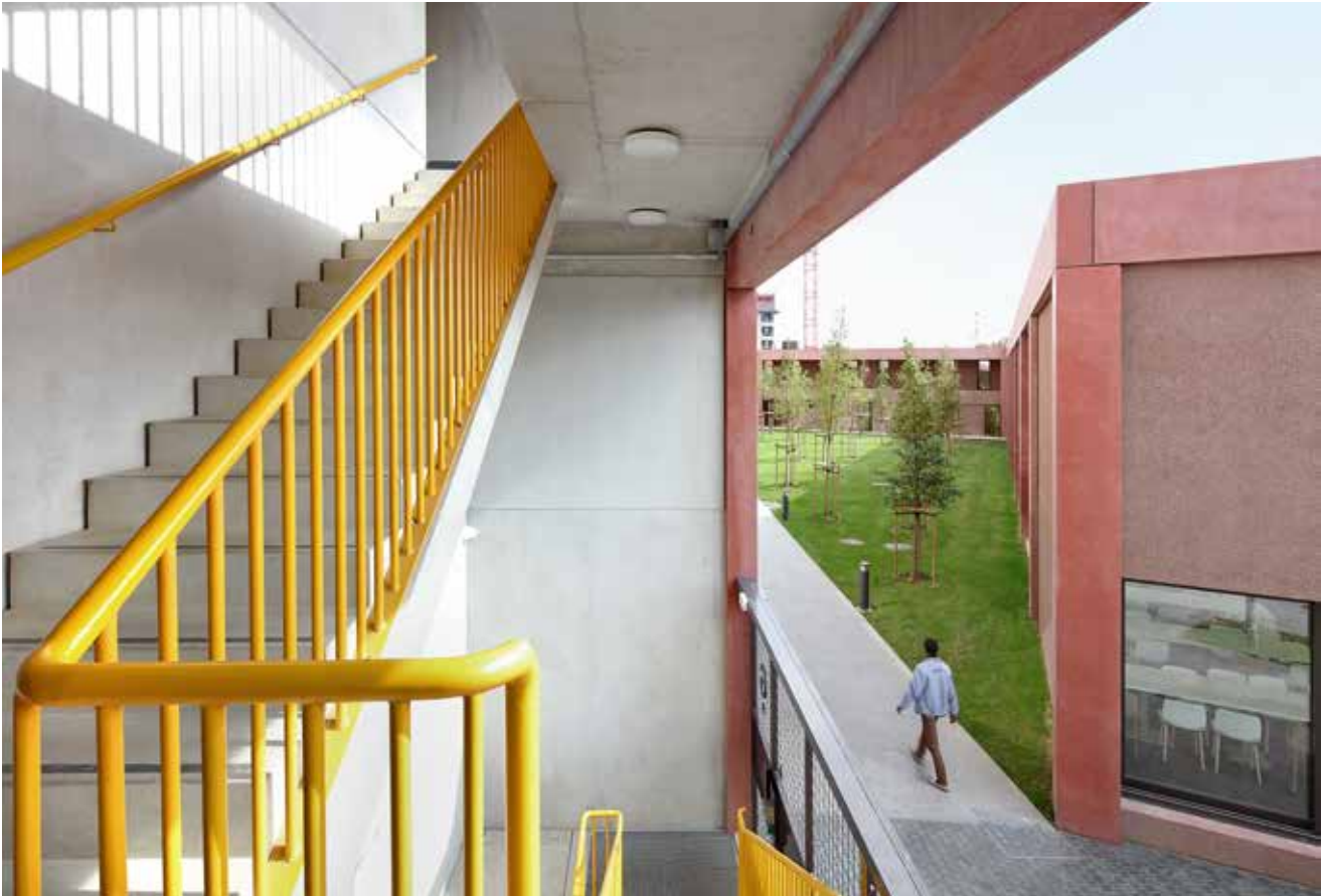
Trois cages d'escalier à l'air libre rythment et traversent le bâtiment principal.
