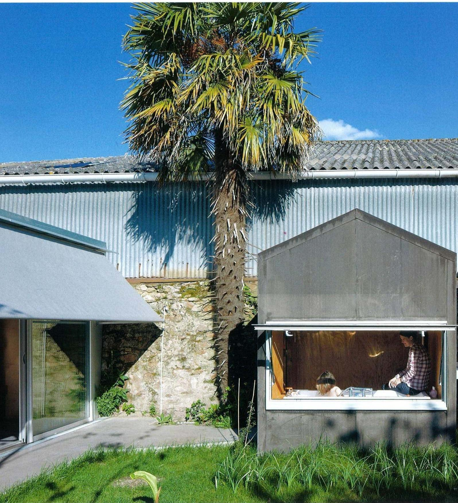
**Bain avec vue** Petit frère de l'extension et proche voisin d'un cabanon présent sur le terrain, ce petit édifice (revêtement en feuille de bitume armé gris Derbigum et ossature en tubes métalliques de 80 millimètres) distille une joie de vivre à la fois dedans et dehors. Tout juste dimensionnée pour y loger une baignoire (modèle Vero
