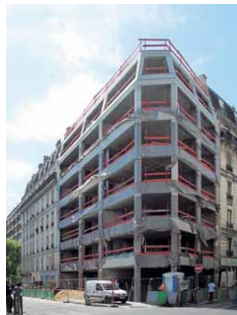
Mise en œuvre du système structurel dessinant les alvéoles dans lesquelles seront placés les ensembles menuisés.
