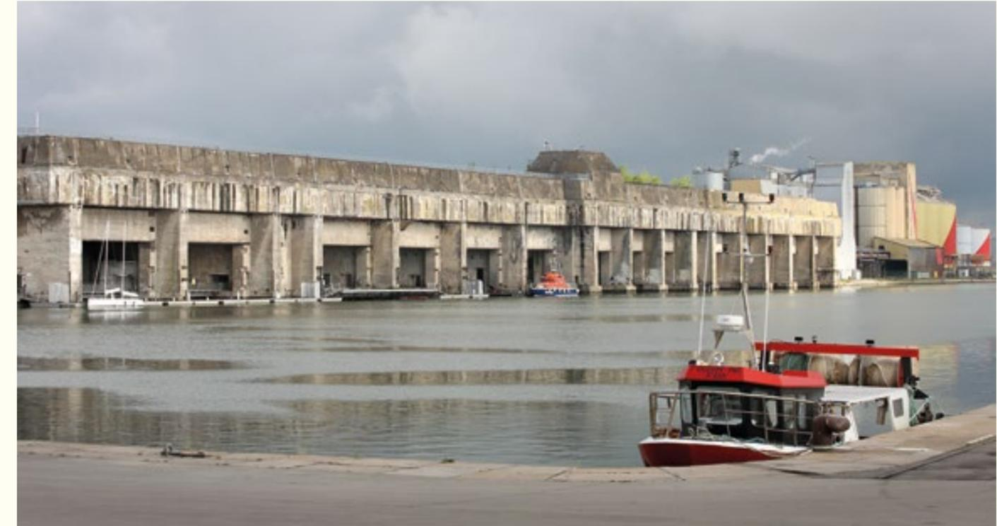
Sur 300 mètres de long, 130 mètres de large et 18 mètres de haut, la base sous-marine de Saint-Nazaire compte 14 alvéoles, pour une surface de 39 000 m<sup>2</sup> comprise dans un volume de béton coulé d'environ 480 000 m<sup>3</sup>.
