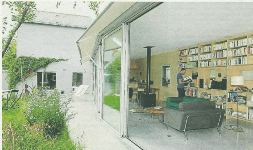
L'extension se raccorde à un angle de la maison, comme « un long ruban qui se déroule sur l'arrière ».
